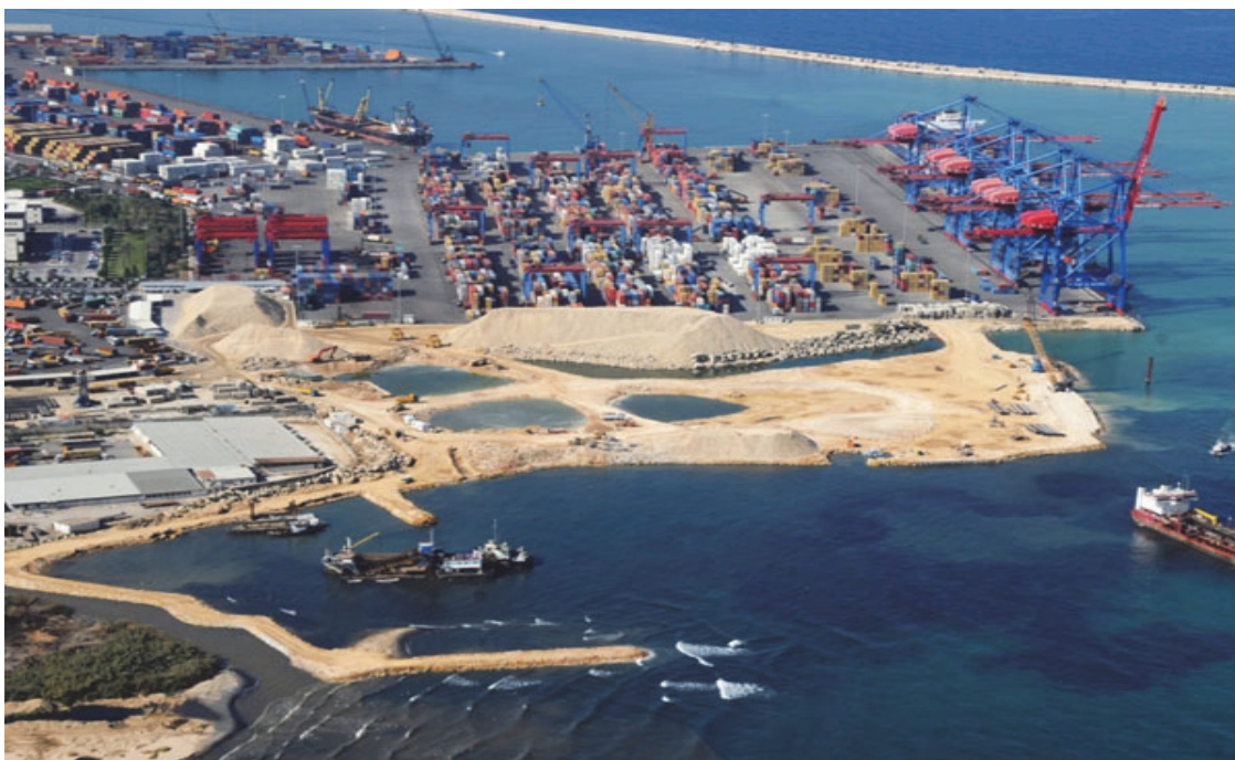
Рис. 14. / Fig. 14. Грузовая площадка порта Бейрут 13 / Cargo area of the port of Beirut
